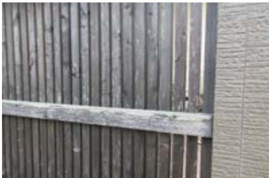
左面部に関しましては、北面という立地条件により、日当たりが悪いことが多く、湿気によるカビやコケなどの汚れの付着が確認されますので、施工の際は、きっちりとした洗浄を行った上での外壁塗装工事をお勧めします。また、木部に関しましては、色褪せなどの発生が確認されますので、塗装をされる際は対策をお勧めします。
