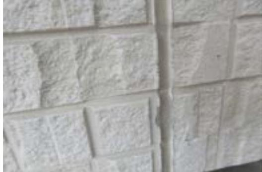
正面部に関しましては、年数的な経年劣化や立地条件により、外壁表面の防水機能の低下が確認されます。また、縦目地や各サッシ廻りにあるコーキングの硬化現象によりひび割れの発生が確認され、一部の縦目地では、隙間の発生が確認されますので、施工の際は対策をお勧めします。
