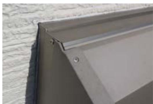
右面部に関しましては、南面という立地条件により、他面に比べ日当たりが良い為、外壁や付帯部の樋やシャッターボックスに紫外線による色褪せが確認されますので、施工の際は、付帯部の塗装の際は、アクリル、ウレタンクラスでの1回塗りでは、施行後、数年で色褪せ、塗膜の剥がれが起きますので、弊社ではシリコンクラス以上の2～3回の重ね塗りをお勧めします。
